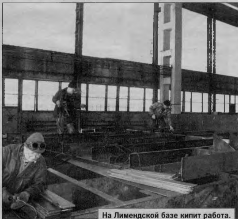
На Лимендской базе кипит работа.
