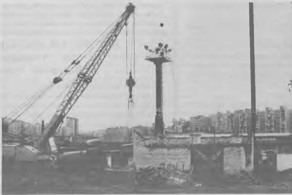
На снимках - недостроенные объекты: слева - здание ремонтной базы, справа - здание очистных сооружений.
