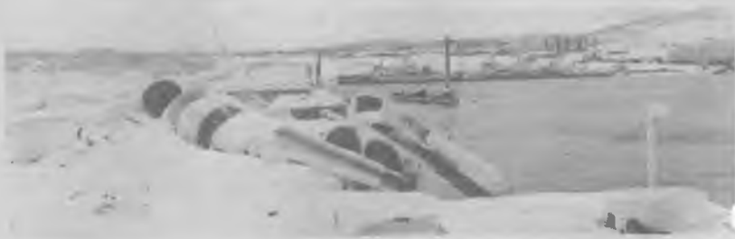
Законсервированное строительство нового нефтепирса.
