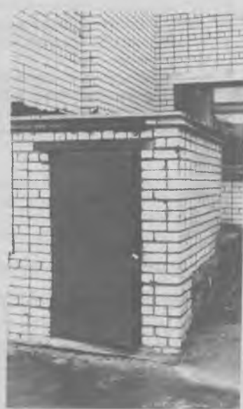
На снимке: вход в подвальное помещение.
