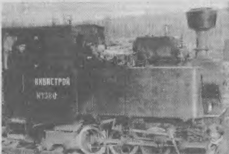
Строительство канала Нива ГЭС-II. 1933 год.
