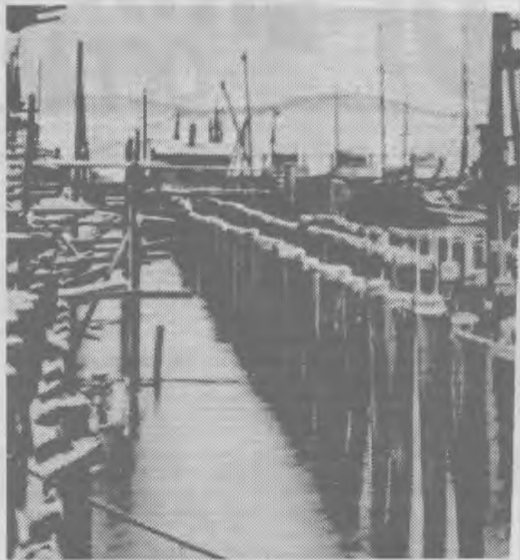
Забивка первых свай Мурманского рыбного порта у Варничного мыса.
