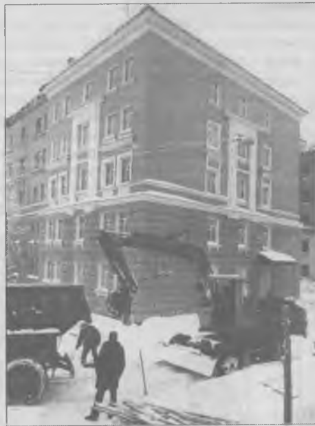
Последний штрих: строители убирают деревянные ограждения.
