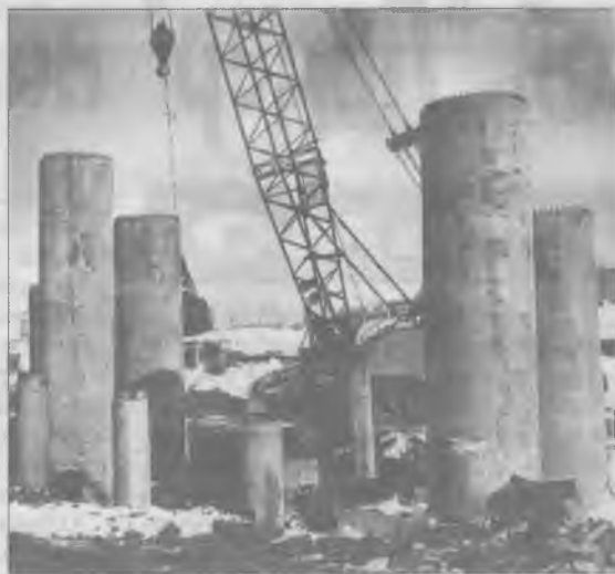
Свайные основания опоры № 5 правобережной эстакады.
