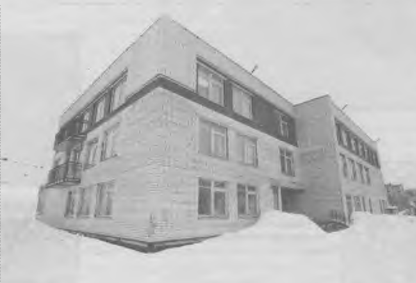
Вот такое здание сумел построить на улице Бочкова в Мурманске коллектив ТОО "Учколлектор".
