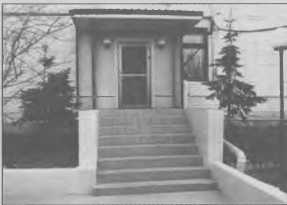
Вход в административное здание и необыкновенная дорожка с подогревом, ведущая к нему.
