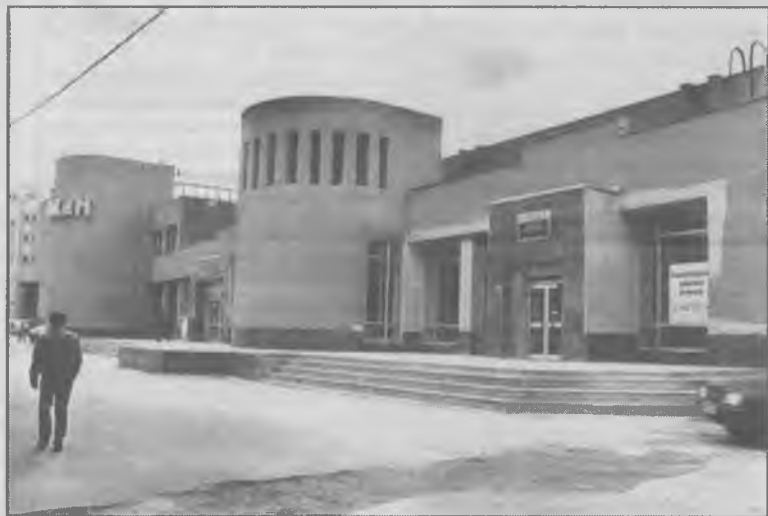
Здание детского театрального центра, где и поселится школа.
