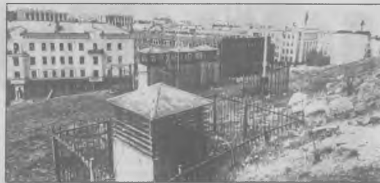
Вентиляционные выходы.
