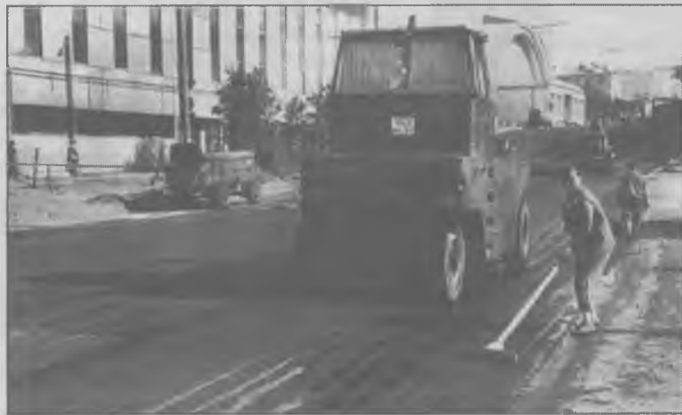
Так укладывается асфальт.
