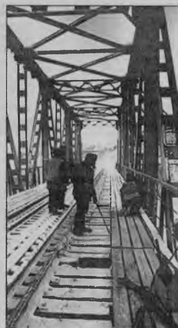
Для пешеходов срочно латают старый железнодорожный мост.
