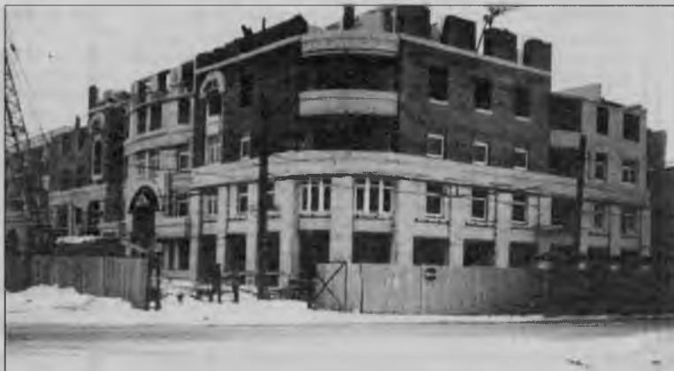
Строительные работы в самом разгаре.
