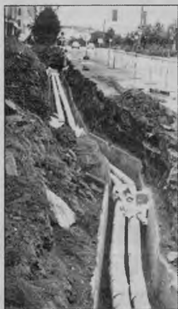
На улице Шмидта заменили трубы тепловых сетей.
