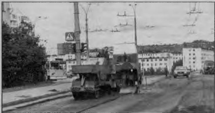
Идет ремонт дороги на улице Радищева.
