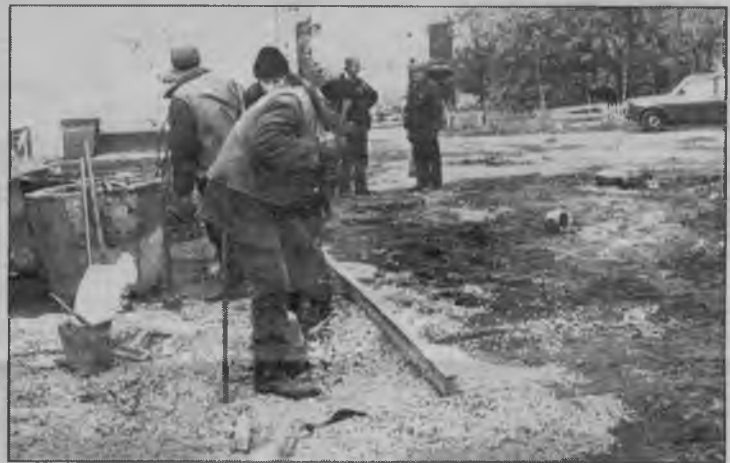
Идут работы по благоустройству территории.
