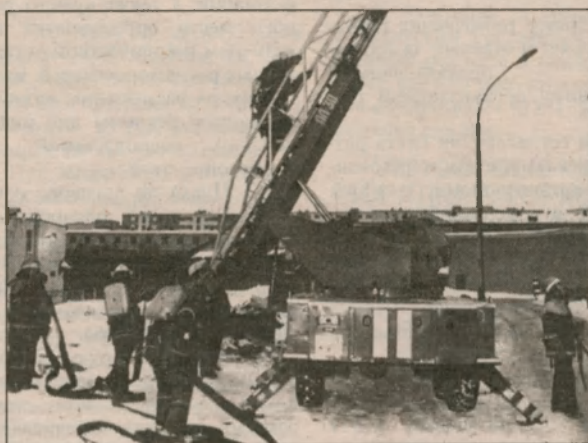
Звено ГЗДС готовится к подъему по автолестнице.
