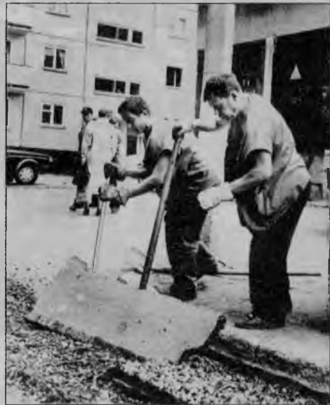
Снимается старое покрытие дороги.
