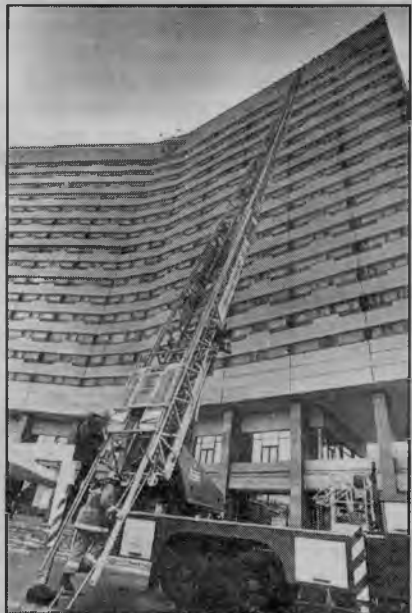
Новая 50-метровая лестница "готягивается" до самых верхних этажей.
