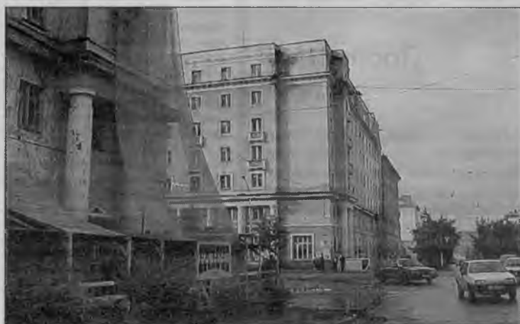
На "близнецах" ремонт только начнется.
