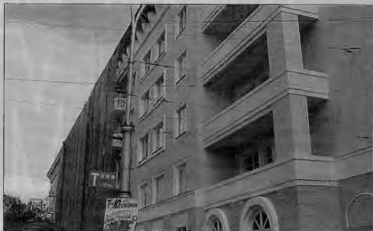
Дом номер 65 на проспекте Ленина вот-вот избавится от строительных лесов.
