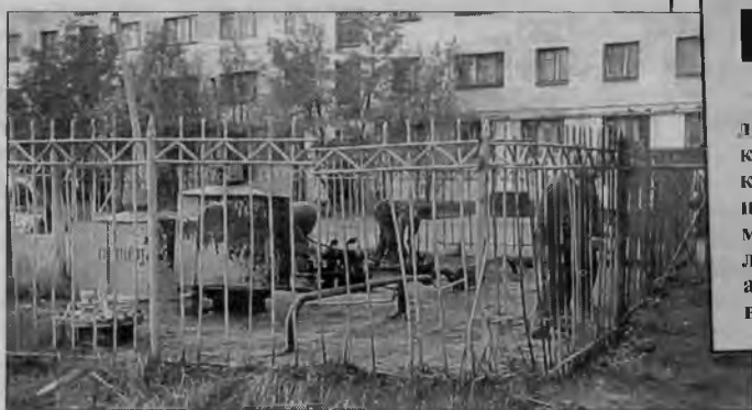
На месте аварии работы почти закончены.
