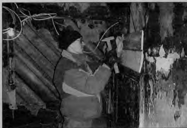
Ремонтные работы начались.
