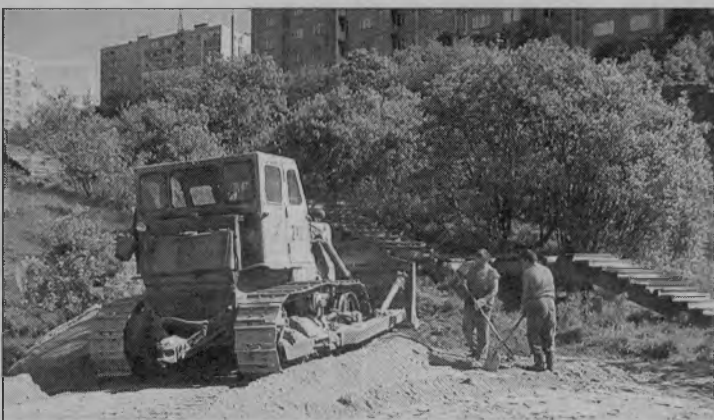
Строится первая смотровая площадка.
