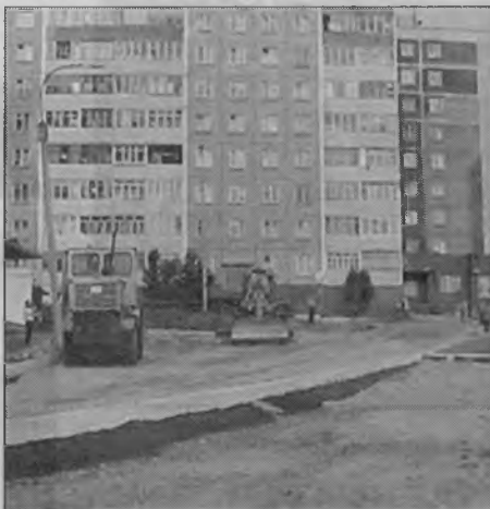
На улице Маклакова продолжают работы по благоустройству.
