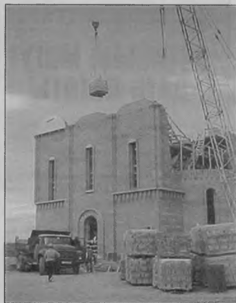
Поднимаются стены морского православного храма Спаса на водах.
