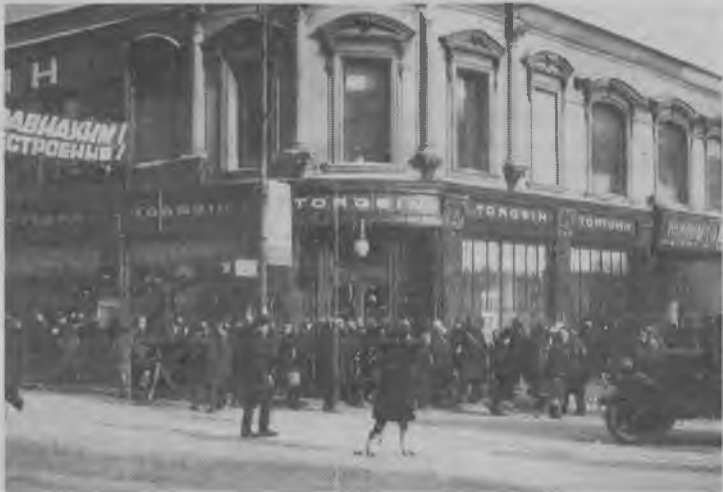
Москва. Здание Торгсина.
