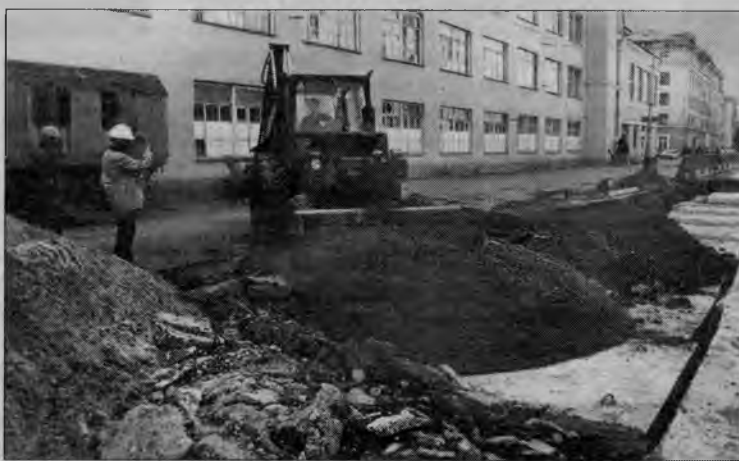
Ремонтные работы на улице Шмидта продолжаются.
