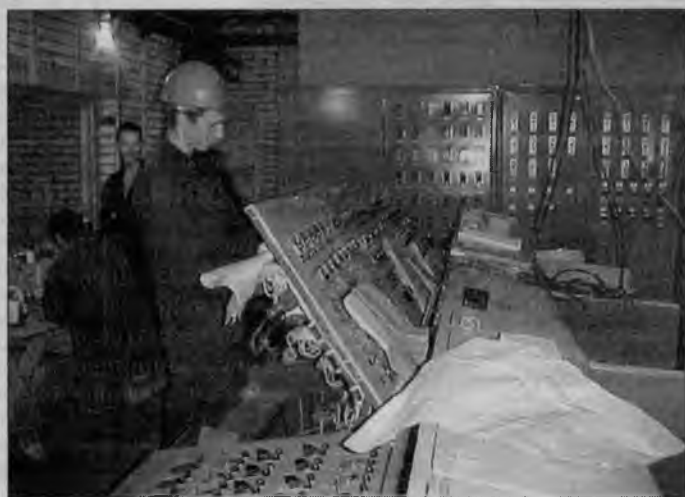
Монтаж системы управления и контроля турбин и вспомогательного оборудования.
