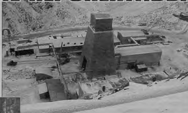
Вентиляционная шахта рудника “Северный-Глубокий”.
