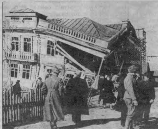
Разрушенное здание областной власти.
