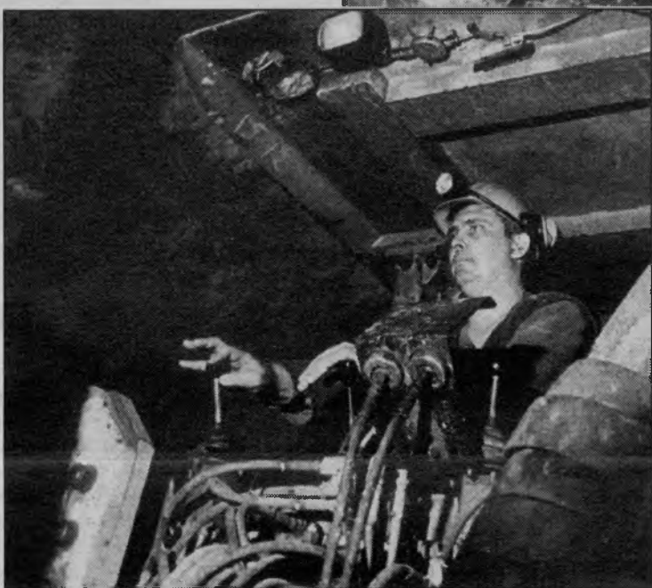
Проходчик Александр Силкин на буровой установке.
