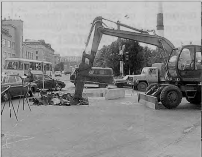
Ремонтные работы на улице Шмидта.
