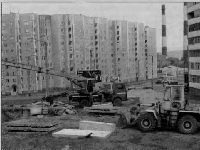
Лето. Работы на теплотрассах в разгаре.
