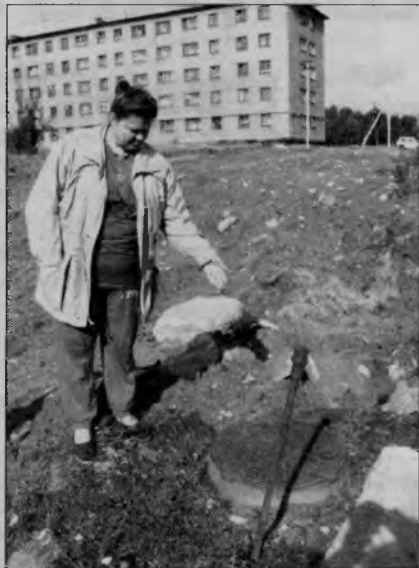
Крышку на колодце сразу заменили.
