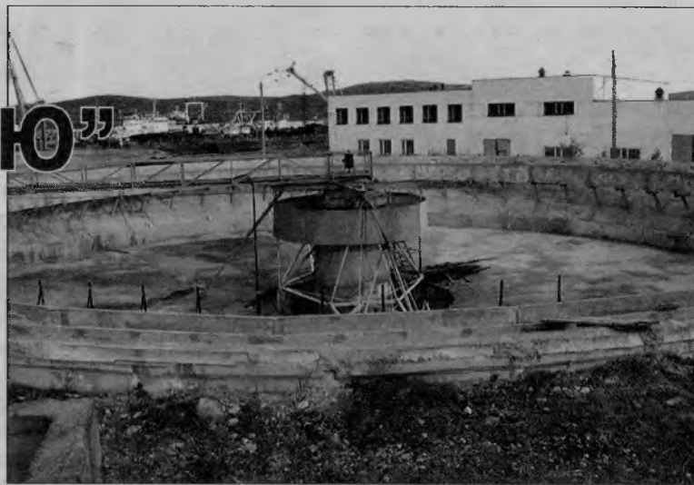
Так выглядит отремонтированный отстойник.
