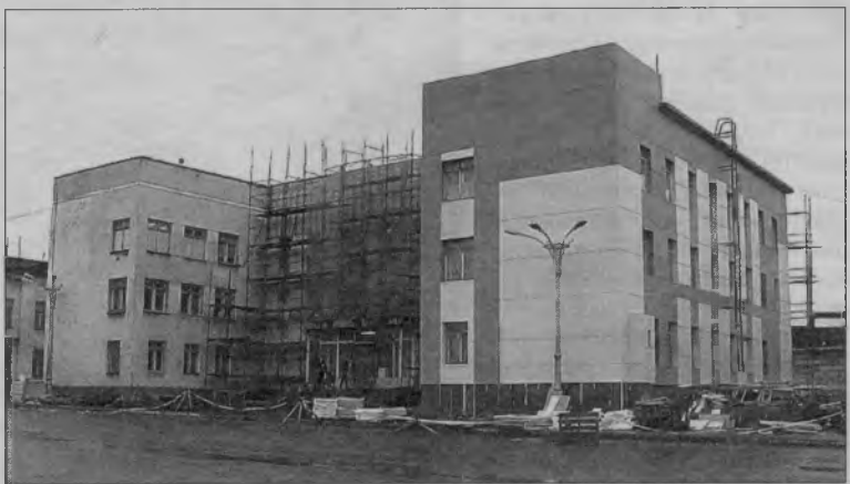
Ремонт здания медсанчасти завершается.
