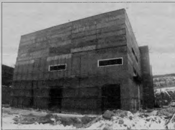
Здесь разместят контейнеры с ОЯТ.
