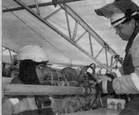
Алексей Третьяков (справа) и Владимир Ильницкий будут монтаж трубы на сп... Мелькёе.
