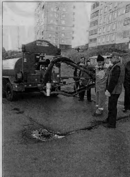
Ямочный ремонт по-новому.
