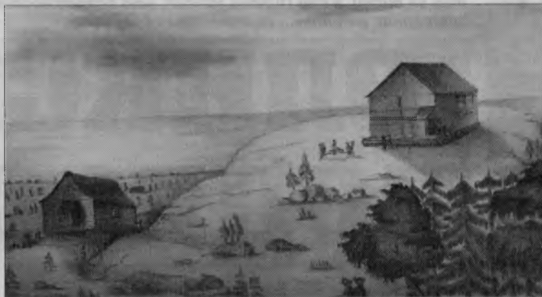
Обсерватория в Умбе (справа).
