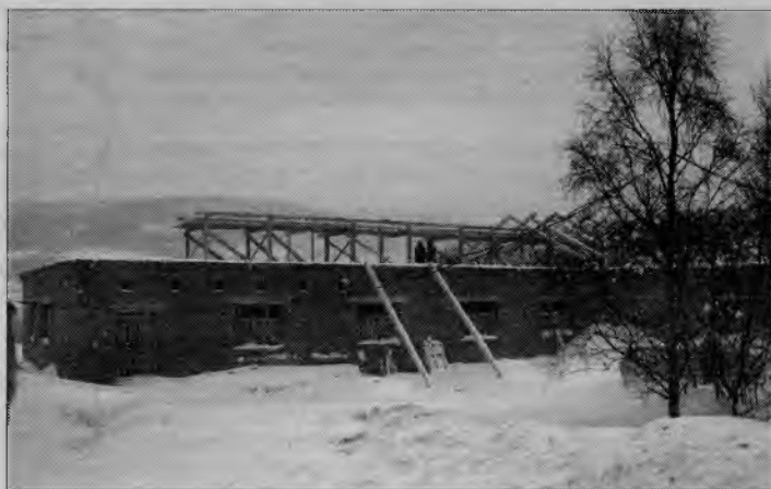
Реконструкция очередного корпуса.
