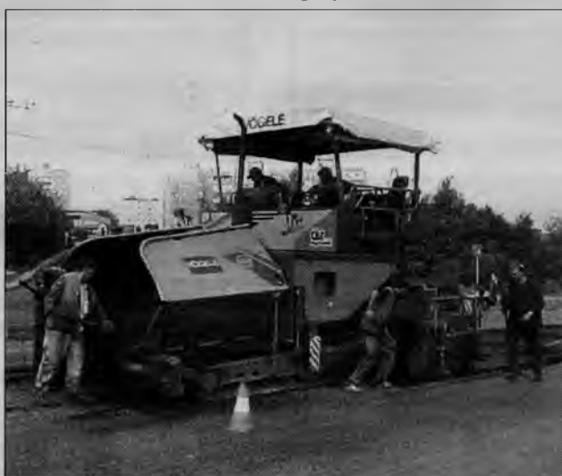
Дорожники "Спецдорстроя" уже освоили немецкий асфальтоукладчик.
