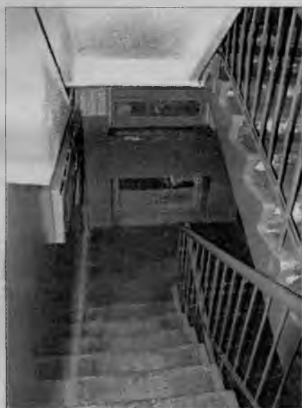
Обновленный подъезд в доме № 27 на улице Книповича.
