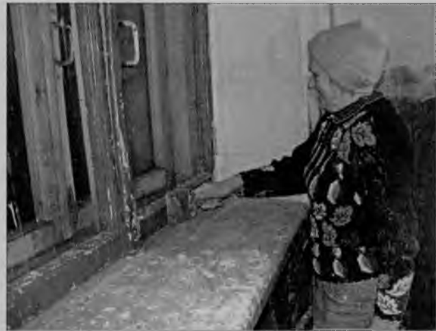
Дом № 2 на улице Дзержинского: "Окнам тоже нужен ремонт".
