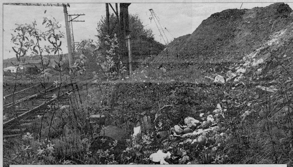
Откосы вдоль железной дороги
