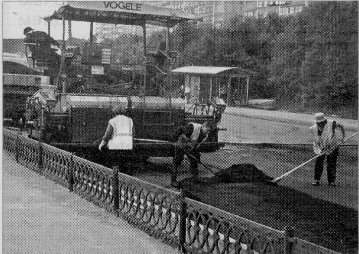
Рабочие укладывают новый асфальт...
