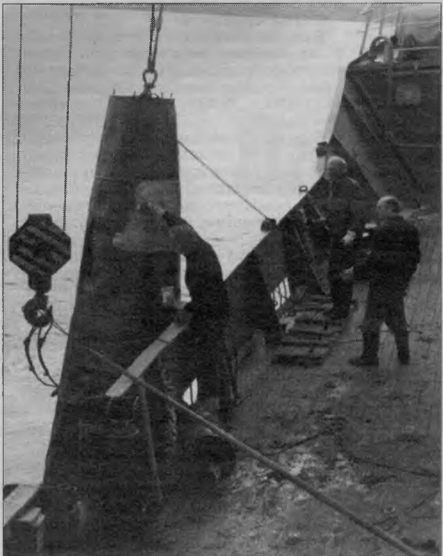
Ремонт плавучего буя.
