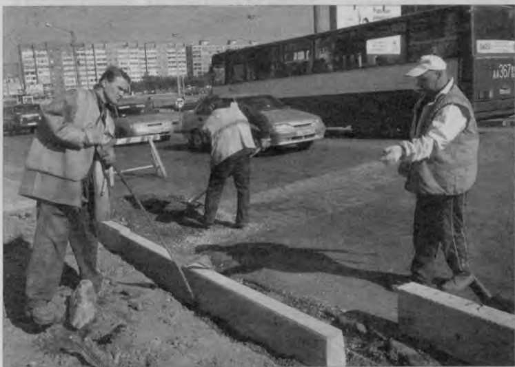
На проспекте Кирова работа еще кипит...
