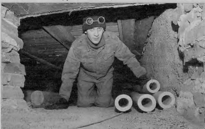
Рабочим пришлось ползать по подвалу на коленях.
